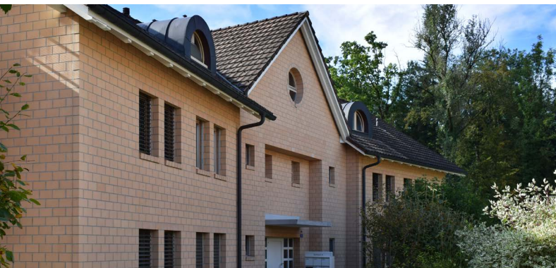
Wohnüberbauung (1998), Rotkreuz (ZG)
